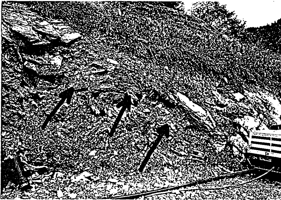
Foto 3: Weitgehend versacktes Felsmaterial, z.T. verfaltet (Pfeile), daneben rechts auch verrutschte Einzelkomponenten (Blöcke).
